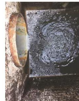
沈殿槽なしで河川放流
