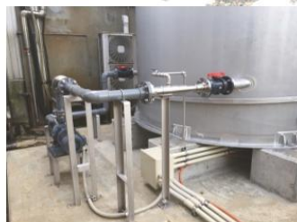
MNB 装置 (陸上ポンプタイプ)
