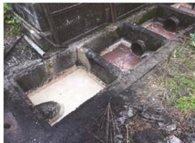
導入前の排水
