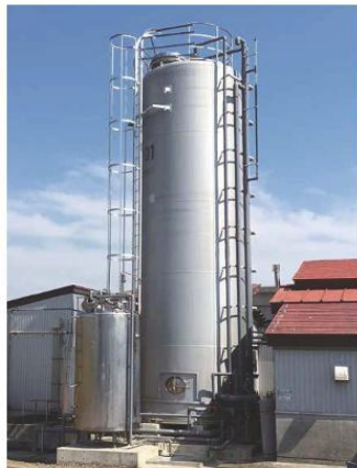
オゾン反応槽と生物処理槽
