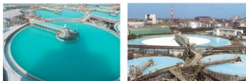
水酸化マグネシウムの製造工場（宇部マテリアルズ・第一工場）
